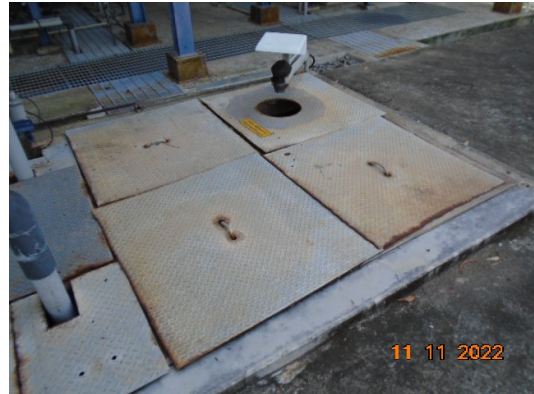
ภาพที่ 2-16 บ่อปรับสภาพน้ำ (Neutralization Pit)
