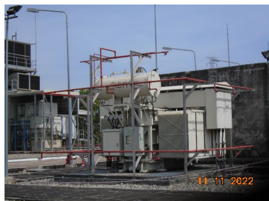
ภาพที่ 2-59 ระบบหัวกระจายน้ำดับเพลิงอัตโนมัติ (Deluge System)
