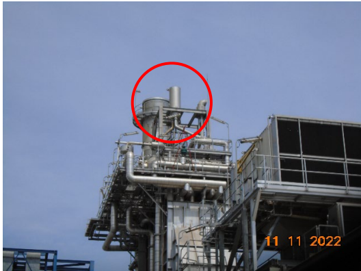
ภาพที่ 2-7 Silencer ที่ Safety Valve
