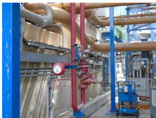
ภาพที่ 2-63 Fire Water Spray System บริเวณ Steam Turbine Generator Bearing Area
