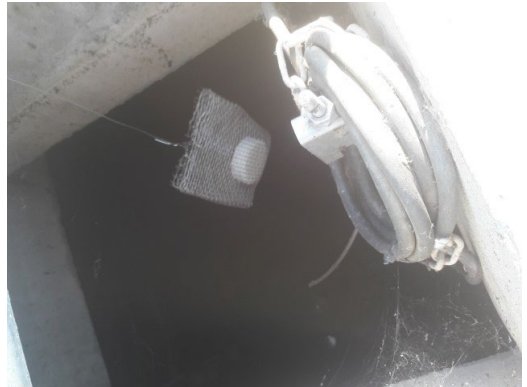
ภาพที่ 2-14 การเติมคลอรีนลงน้ำทิ้ง
