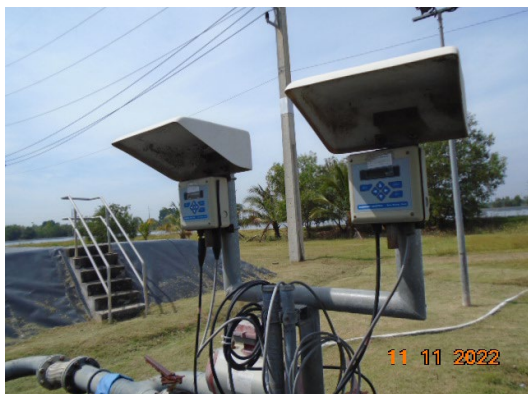
ภาพที่ 2-19 pH Online และ Conductivity Online บริเวณบ่อพักน้ำทิ้ง
