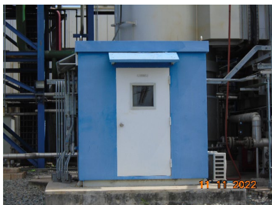
ภาพที่ 2-3 ระบบ CEMS ของปล่อง HRSG#12
