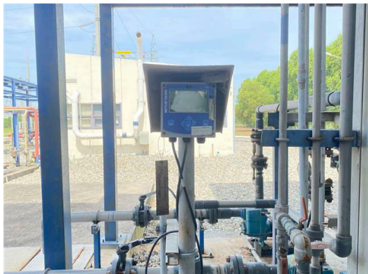
ภาพที่ 2-17 pH Online บริเวณบ่อปรับสภาพน้ำ (Neutralization Pit)
