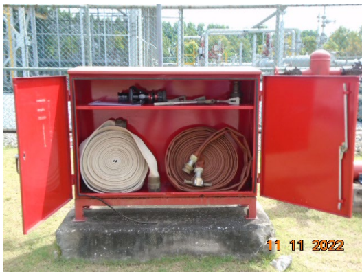
ตู้เก็บสายส่งน้ำดับเพลิง (Fire Hose Cabinet)
